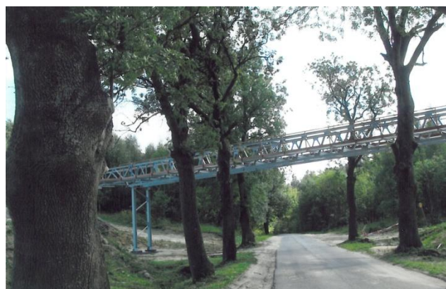
Sieniawa wrzesień 2011 – droga w kierunku na Wielowieś, transport z nowego siodła
